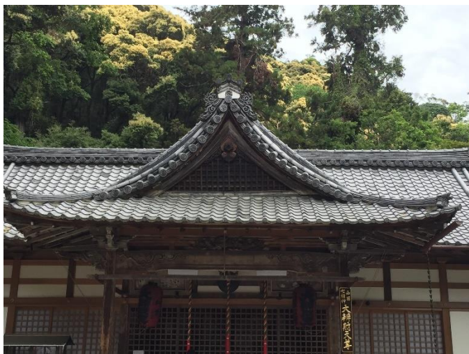
(写真は、瀧安寺境内にある大弁財天です)
